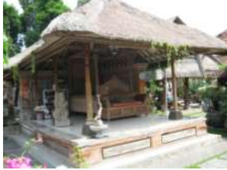
Foto 5.3 : Bangunan Bale Daging
