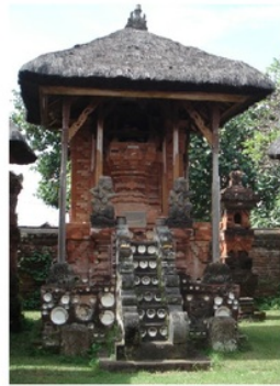
Gambar 5. Penggunaan piring keramik pada bangunan kuno Pelinggih Bhatara Brahma di Puri Satria Denpasar
