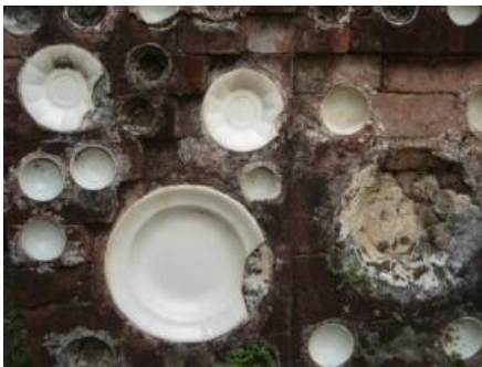
14. Detail porselin pada pojok kanan depan bagian bawah bawah bangunan.
