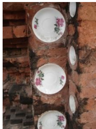
56. Tampak detail ornamen lepekan keramik pada Pelinggih Taksu.
