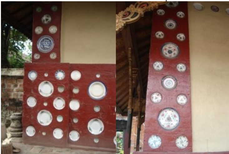
231.Tampak dari selatan bagian depan pojok barat.
