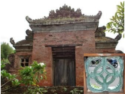
53. Kori agung, salah satu bangunan peninggalan masa lalu yang masih kokoh berdiri di jaba sisi menghadap kebarat.
