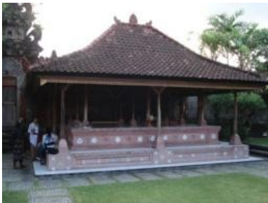
74. Tampak detail pemasangan porselin
