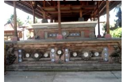
332. Tampak samping selatan detail bangunan Bale Pegat .
