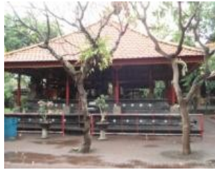
84. Bangunan Bale Sumanggan dari utara.
