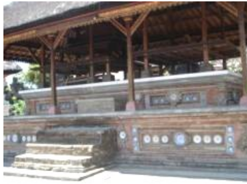
331. Tampak depan detail bangunan Bale Pegat .
