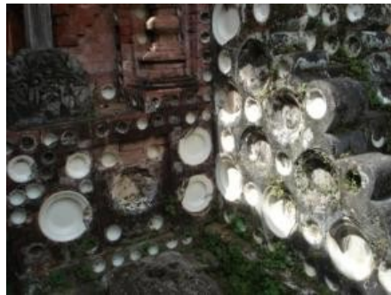
15. Detail porselin pada bagian luar undagan dari arah utara dan pojok kanan depan bagian bawah bangunan.
