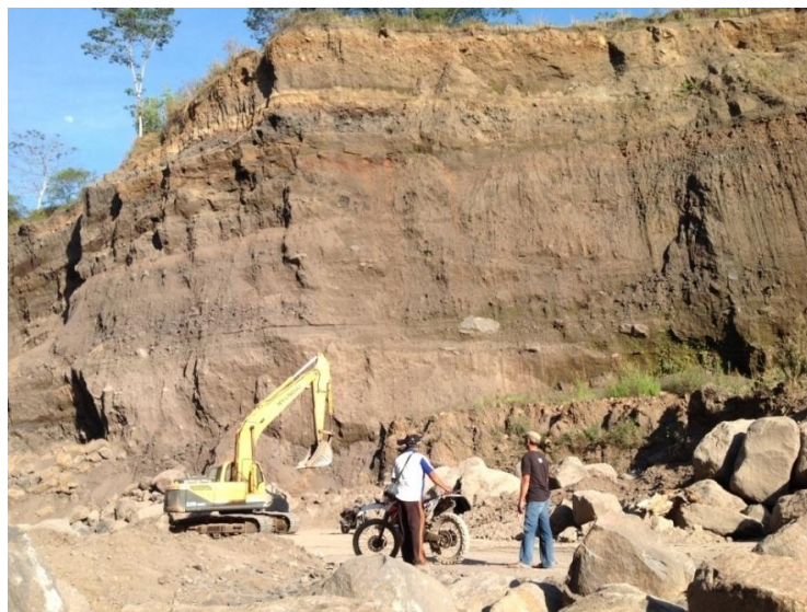
Gambar 12. Rusaknya struktur tanah di areal penambangan pasir berpotensi terjadinya tanah longsor. (Dokumentasi: I Wayan Setem 2020).
