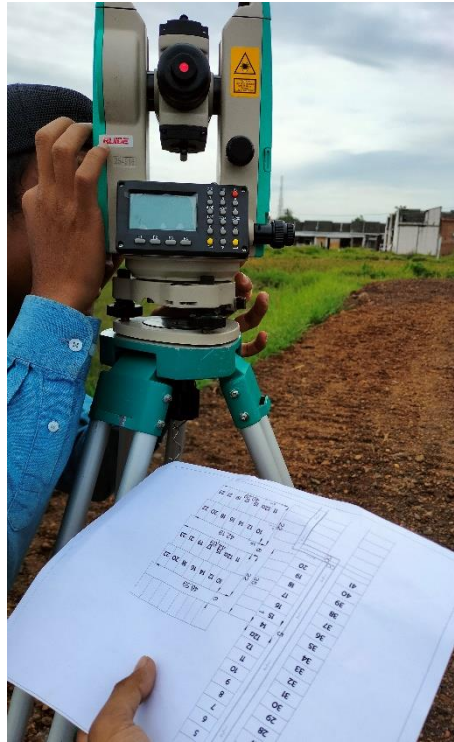
(pematangan lahan pembangunan
