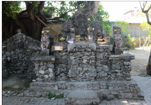
Gambar 5. Aplikasi Batu Kapur pada bangunan pura di Pura Segara
