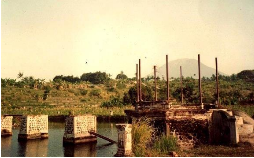
Gambar 6.3 Pondasi jembatan dan Gardu Jaga Taman Ujung saat dalam Kondisi Rusak
