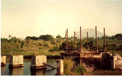
Gambar 6. 3 Pondasi jembatan dan Gardu Jaga Taman Ujung saat dalam Kondisi Rusak
